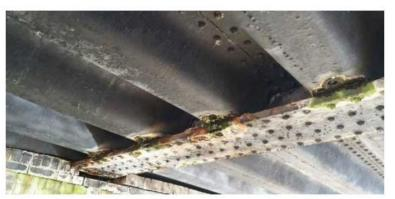
LOCALISED CORROSION OF TROUGHING
