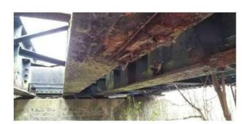
LOCALISED CORROSION IN MAIN GIRDER BOTTOM FLANGE
