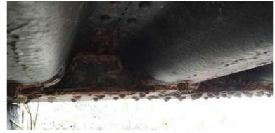
LOCALISED CORROSION OF TROUGHING
